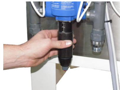
Mittels Einstellrad auf die erforderliche Zumischrate justieren
